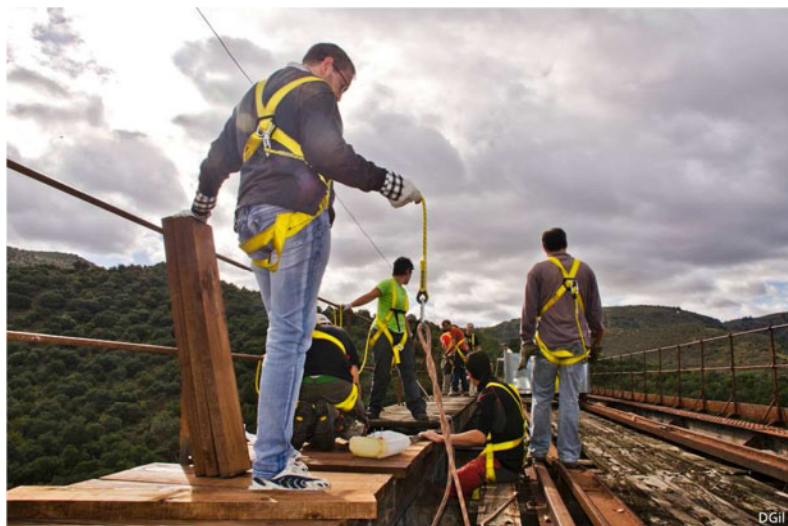
Fig. 7 - Acção de reabilitação de uma ponte Ferroviária pela associação Tod@via.
