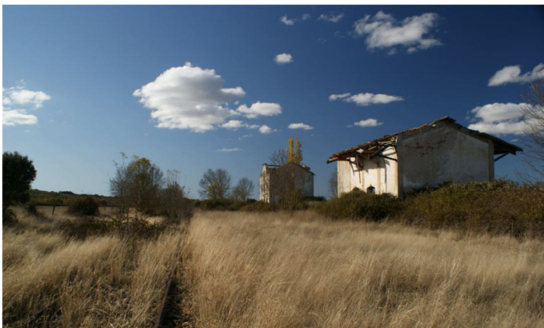
Fig. 4 - Crescimento da vegetação nas imediações da estação.
